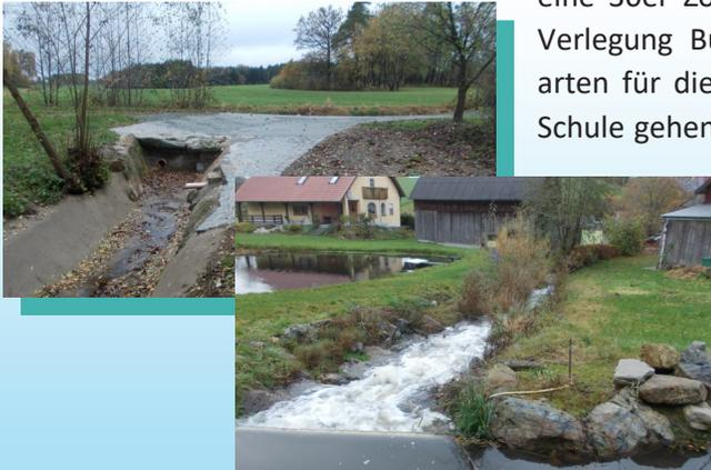
Für den **Hochwasserschutz** wurde in Tressau der Mühlgraben saniert und eine Flutmulde gebaut.
